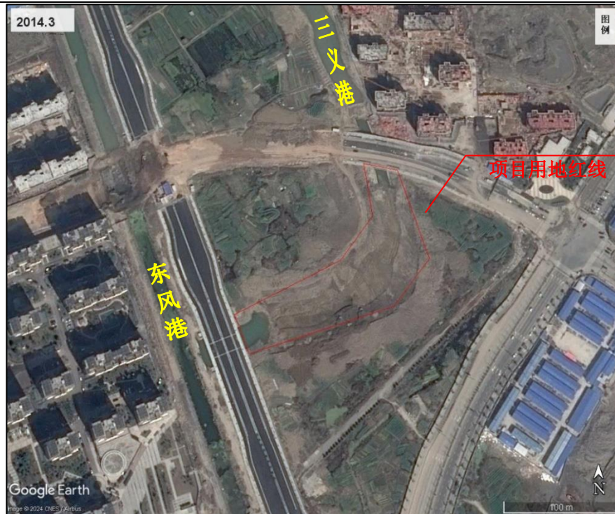
图 7-2 施工期周边河道
